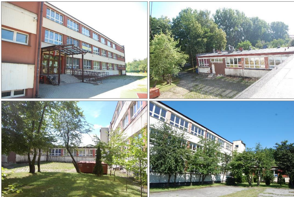
Rys. 1. Budynek w stanie istniejącym.
