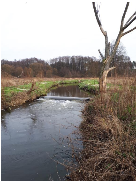
Rys.7. Próg piętrzący na rzece Mieni.
