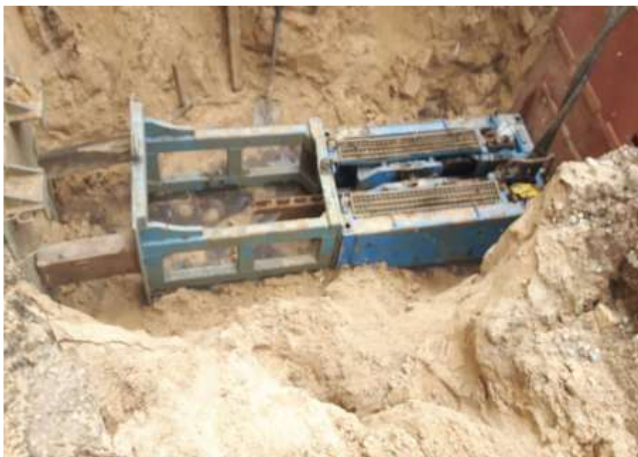
Rys. 6. Maszyna do odnowy sieci kanalizacyjnych i wodociągowych w technologii krakingu statycznego (komorowa).
